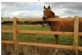
Pose des lisses bout à bout
