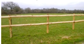
Pose des lisses bout à bout
