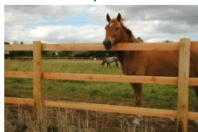
Pose des lisses bout à bout
