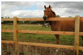
Pose des lisses bout à bout
