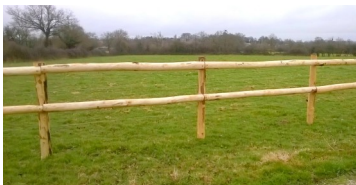
Pose des lisses bout à bout
