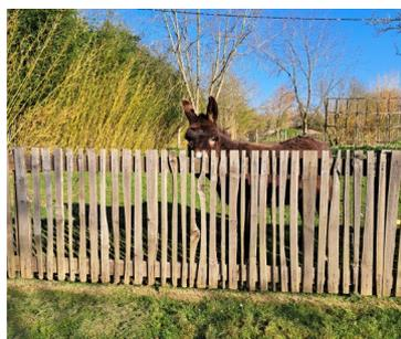
Barrière rigide en échelas sciés de châtaignier, écart de 4 à 5cm entre les échelas, assemblée dans nos ateliers par agrafage sur 2 traverses horizontales
