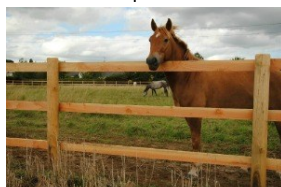
Pose des lisses bout à bout
