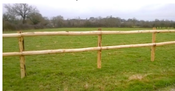
Pose des lisses bout à bout
