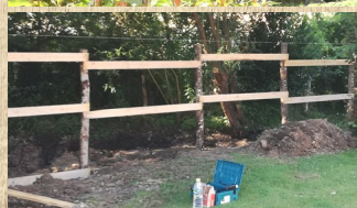
Structure de la palissade
