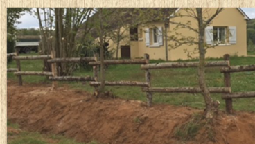
Lisses 1/2 rondes diam. 11/14cm Lg 2m, pose en quinconce sur des poteaux diam. 11/14cm Lg 2m
