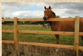
Lisses sciées équarries: Lg 2m x 12cm x 3.5cm pose bout à bout sur des poteaux diam. 14/16cm Lg 2m
