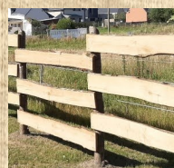
Lisses 1/2 rondes diam. 11/14cm Lg 2m, pose en quinconce sur des poteaux diam. 11/14cm Lg 2m
