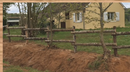
Lisses 1/2 rondes diam. 11/14cm Lg 2m, pose en quinconce sur des poteaux diam. 11/14cm Lg 2m
