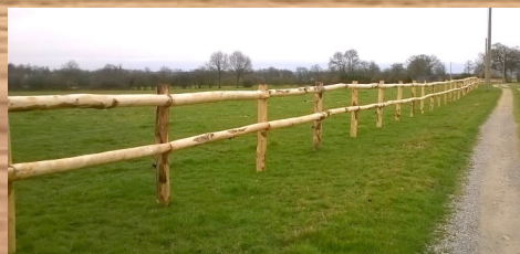
Lisses 1/2 rondes diam. 11/14cm Lg 2m, pose bout à bout sur des poteaux diam. 14/16cm Lg 2m
