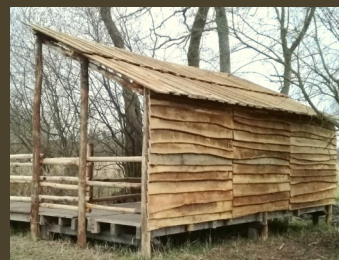
Piquets de construction de diam. 14/16 à 16/18cm et +
