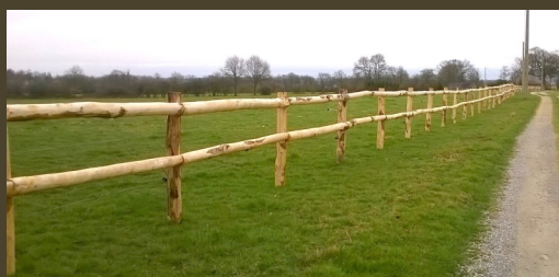
Lisses 1/2 rondes diam. 11/14cm Lg 2m, pose bout à bout sur des poteaux diam. 14/16cm Lg 2m
